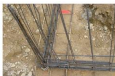
Nœud de chaînage - Continuité mécanique
